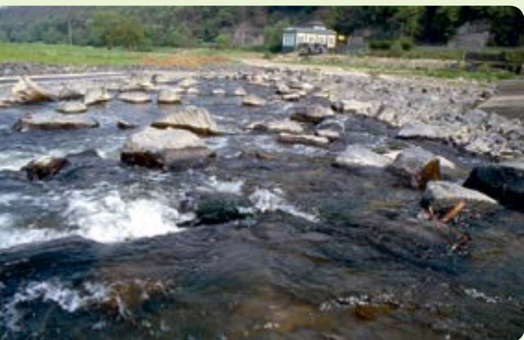
Fischpass an der Unkelmühle
